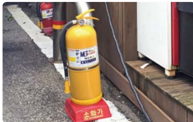
광장동 주민센터 옆 전기차 충전소 소화용 덮개 및 소화기 설치
