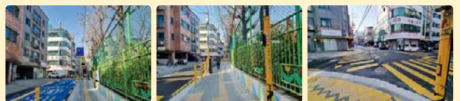
눈에 잘 띄는 보도 신설 및 확장, 교통안전시설물 설치
