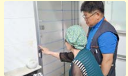
군자동 주거 취약가구 '소규모 집수리 지원사업' 현관 방충망 설치
